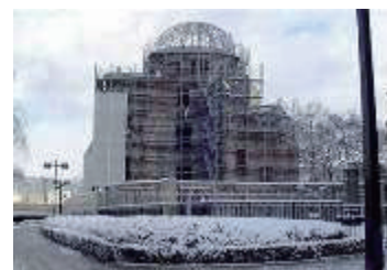
原爆ドームでの耐震工事
